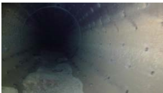
集水埋渠内の目視調査写真
