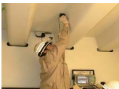
鋼床版 SAUT の計測
