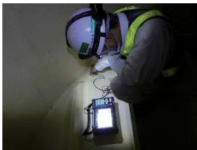
鋼製橋脚隅角部調査
