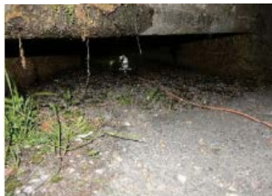
道路下の溝橋
