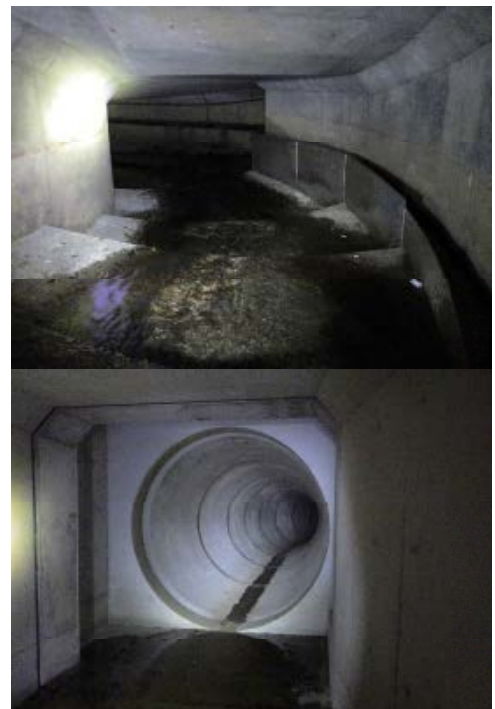
【写真】（上）西谷川（ボックスカルバート） （下）観音寺川放水路（セグメント）
