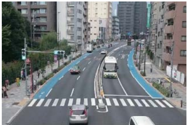
日常的な道路ネットワークを支える道路整備の例
