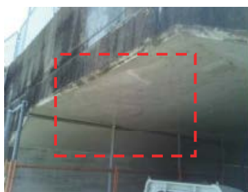
溝橋天端赤外線撮影範囲
