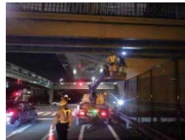
横断歩道橋点検
